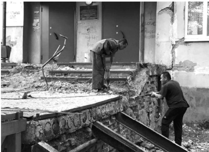
20 июня в здании Дома быта началась реконструкция входной группы, в рамках которой будут произведены демонтаж старого крыльца и установка нового с прорезиненным покрытием.
